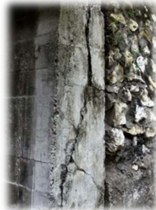
(a). Retakan Tembus Hingga Sisi Dalam
